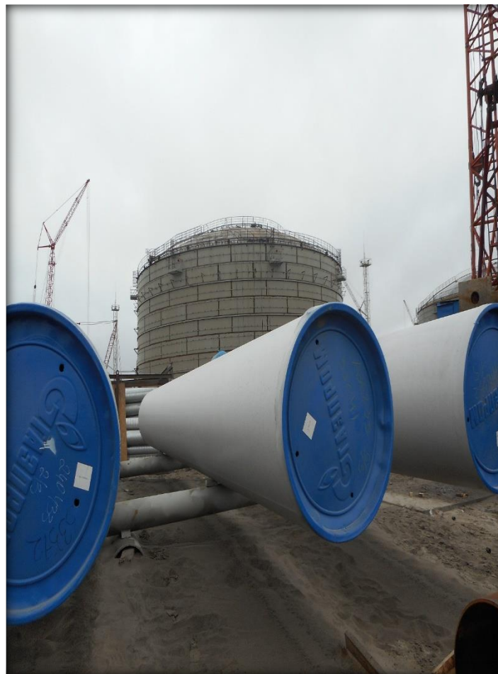
Masscoroxy 1264 – 160 мкм Masscorur 14 – 60 мкм Общая толщина: 220 мкм
