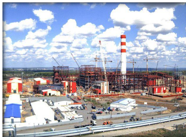
Строительство объектов ПАО «НЛМК» «Стойленский ГОК» г. Старый Оскол
